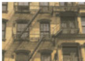
пожарная лестница požarne stepenice
