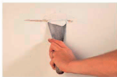
шпаклевать shpaklevat' | fill (v)
